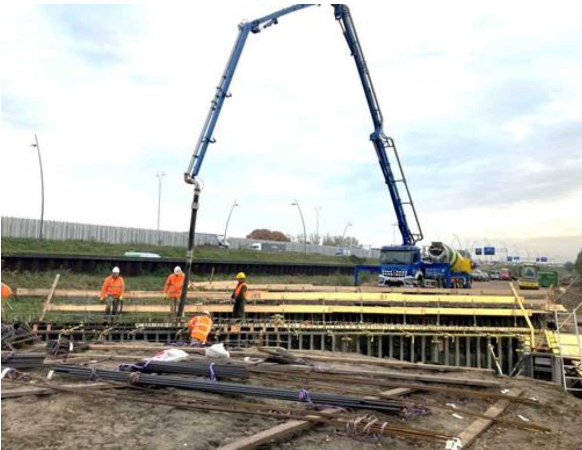
Betonstort landhoofden Genderbrug
